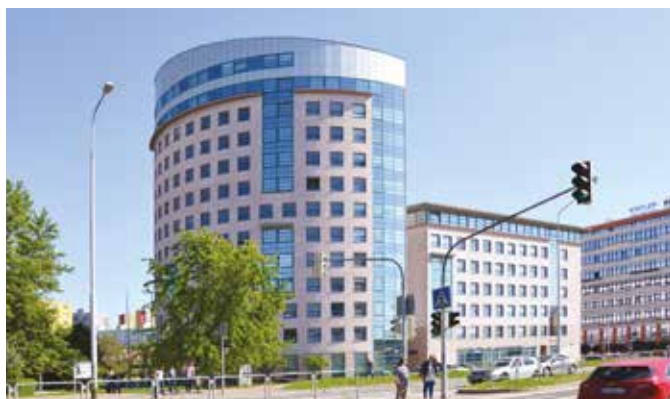
Daňové riaditeľstvo, Bratislava, Ševčenkova (podlahové vykurovanie Gabotherm®, 1 000 m 2 , rozvody vykurovania)
