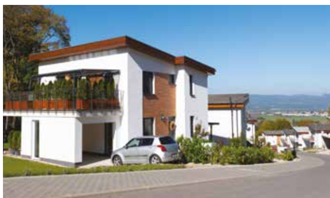
Rodinné domy Medové lúky, Kolačím (podlahové vykurovanie Gabotherm® 1.2.3.)
