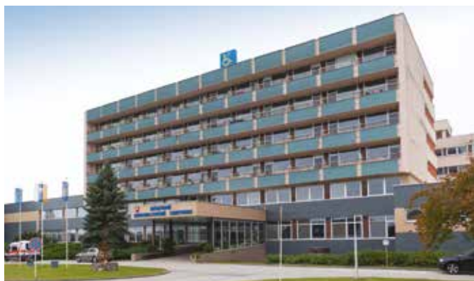
Národné rehabilitačné centrum, Kováčová (podlahové vykurovanie Gabotherm®, 450 m 2 )
