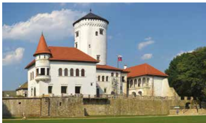
Budatínsky zámok, Žilina (podlahové vykurovanie Gabotherm®)
