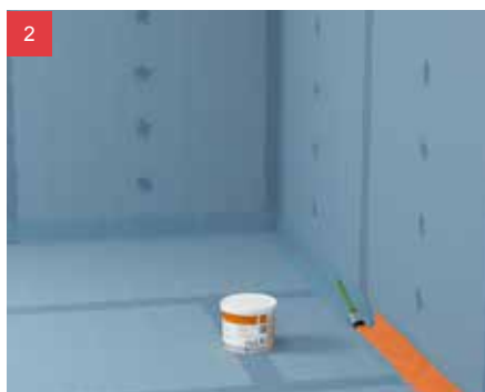
2 V rohu použijte tekutou fólií fermacell®.
