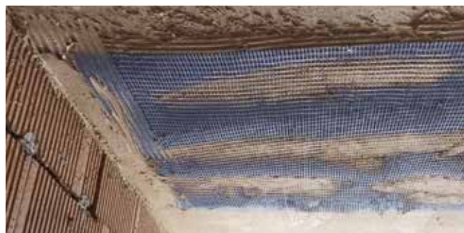
6. Instalace sklotextilní výztuže
