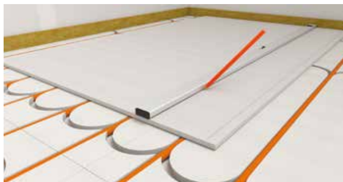
Označte upevňovací body a osy.
