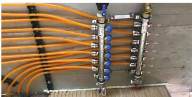
4. Montáž rozdělovače
