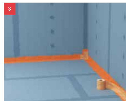
3 Zatlačte těsnící pásku fermacell® do vlhké tekuté fólie.
