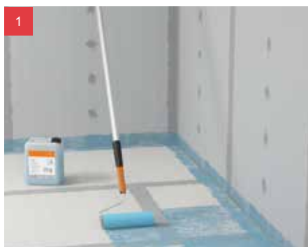
1 Na přilehlou plochu stěn a podlahy naneste válečkem hloubkovou penetraci fermacell®.
