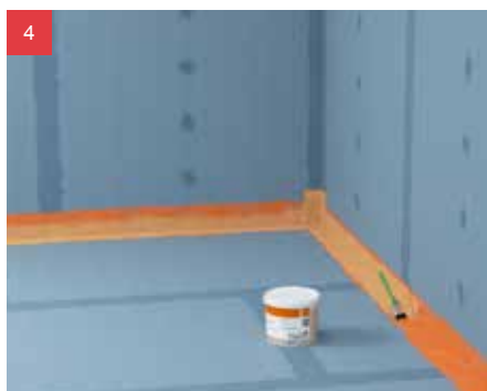
4 Těsnící pásku přetřete tekutou fólií fermacell® ihned po přitlačení.
