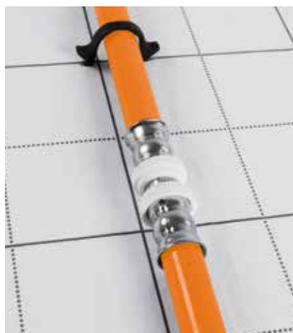
4. Detail uložení trubek na systémovém pásu
